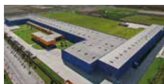
Hörmann Tianjin, Chine
